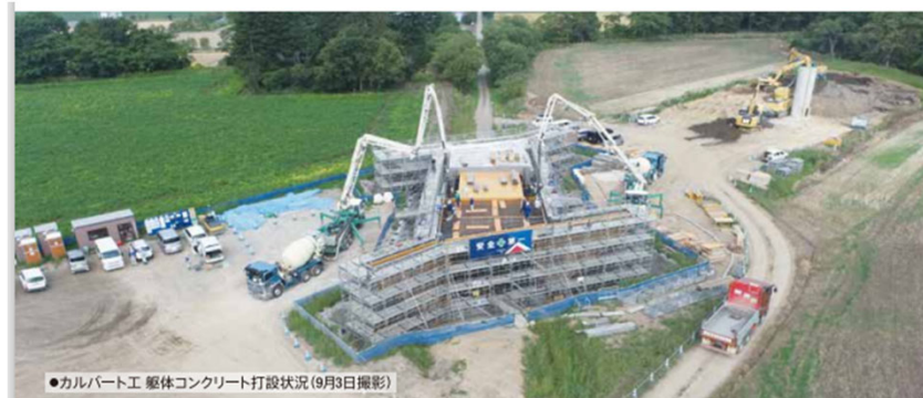
●カルバート工 躯体コンクリート打設状況(9月3日撮影)
