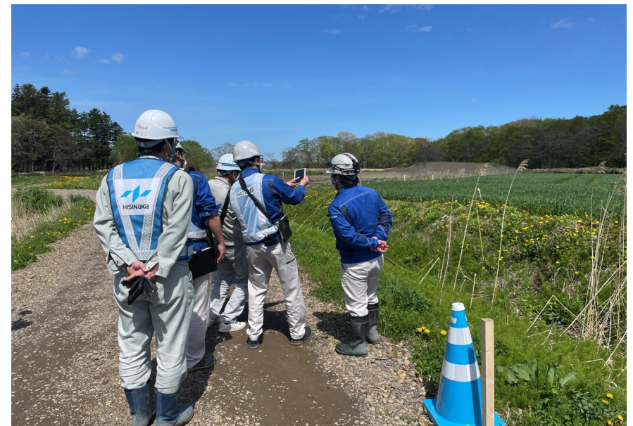
ARを活用した工事内容説明状況
