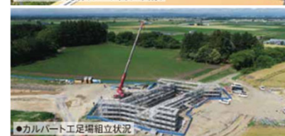
●カルバート工足場組立状況
