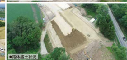
●路体盛土工状況
