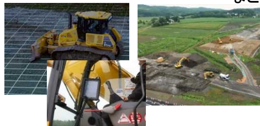
ICT建機での施工
